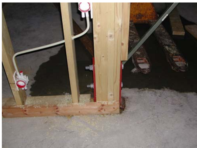
Figur C.3 Förankring av lyftkrafter till betong
